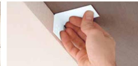
Приклейте фиксирующий уголок к потолку в нужной точке с помощью временной примерки теплоизоляционной плиты.
