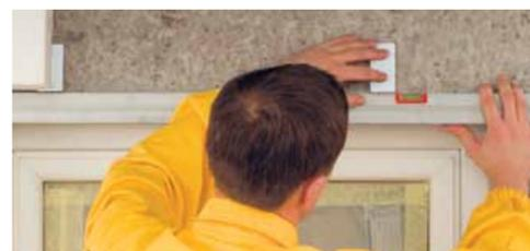
Затем прижмите фиксирующий уголок в месте установки над проемом окна так, чтобы полистирольная плита могла быть помещена на его меньшую сторону.
