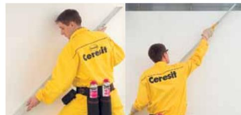
Откорректируйте строительным уровнем ровность теплоизоляционного слоя не позже, чем через 20 мин после приклейки.
