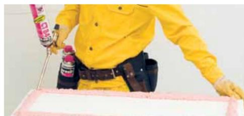
Наносить Ceresit CT 84 необходимо движением "на себя" по оси монтажного пистолета.
