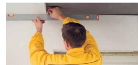
Зафиксируйте теплоизоляционную плиту в рабочем положении с помощью шпильки, продетой через фиксирующий уголок.
