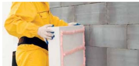
После нанесения клея прижмите теплоизоляционную плиту и временно зафиксируйте длинной рейкой.
