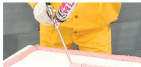
Наносить Ceresit CT 84 следует по периметру плиты, отступив от края 2 см.
