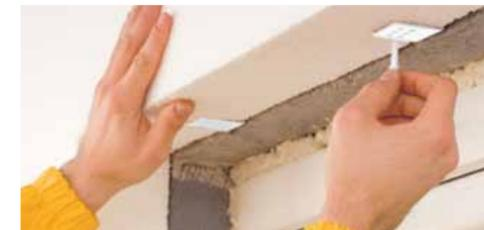
Зафиксируйте теплоизоляционную плиту над проемом с помощью временной шпильки, продетой через фиксирующий уголок.
