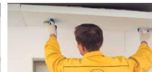
Приклейте следующую плиту и зафиксируйте, сдвинув на выступающую часть шпильки.
